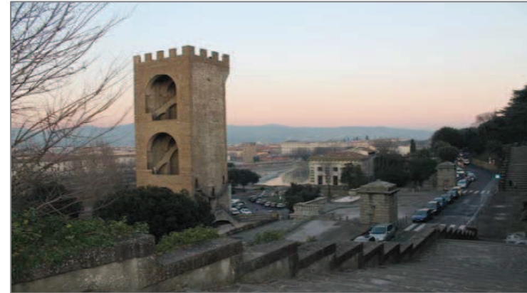
La Torre San Niccolò e le Rampe
